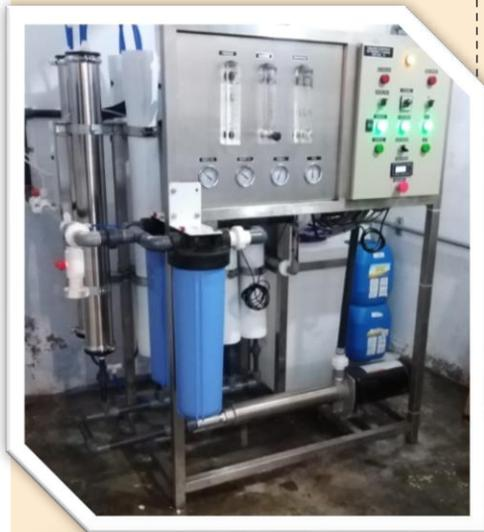
Para el diseño de la planta de osmosis inversa se selecciono membranas que permitan obtener un alto rechazo de sales considerando que la conductividad de ingreso es de 5,200 uS/cm y tener de permeado como máximo un valor de 120 uS/cm; dentro del catalogo de membranas LG se empleo el modelo BW4040R
